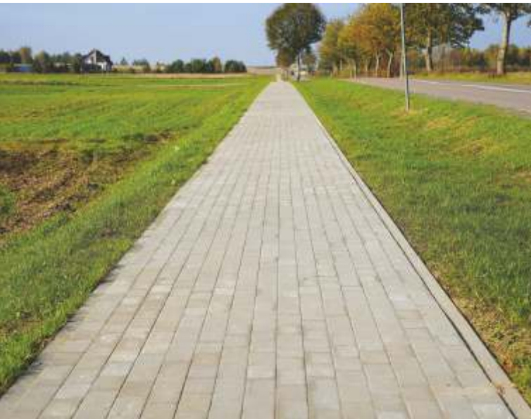
Nowy chodnik na terenie Gminy Linia
